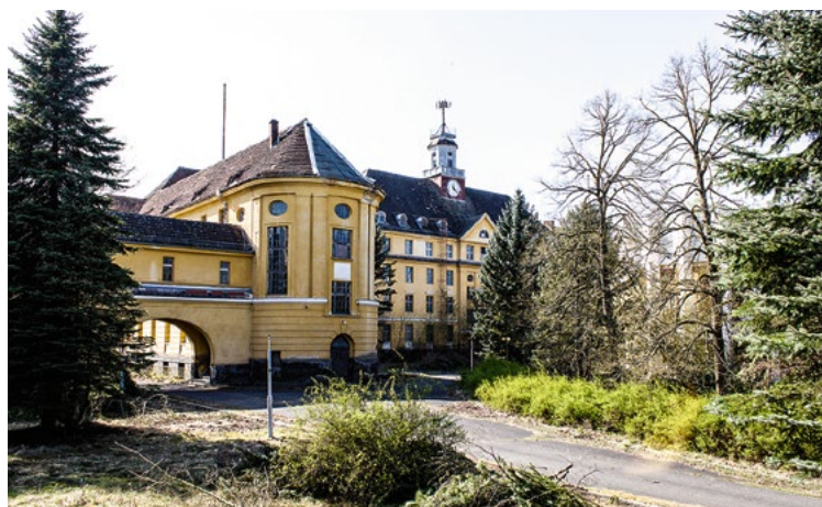
Die Eco City möchte die verfallenen Bauten energetisch umbauen. Eines der Häuser würde dann etwa zur Ausbildungsstätte werden.
