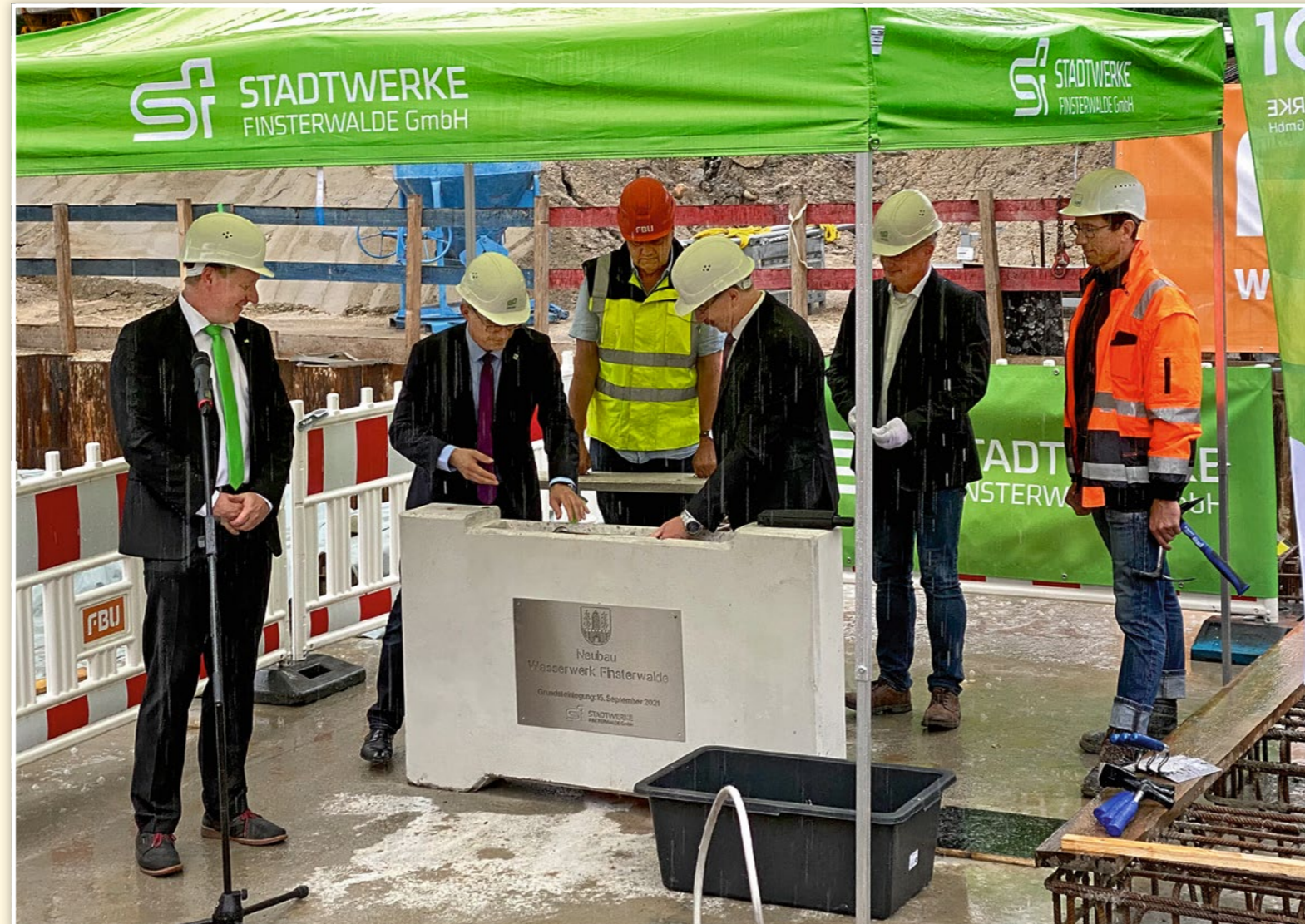
Wasser war zur Grundsteinlegung reichlich vorhanden: es regnete in Strömen. Die Stadtwerke-Geschäftsführer Andy Hoffmann (l.) und Jürgen Fuchs (3. v. r.), Bürgermeister Jörg Gampe (2. v. l.) und Thomas Freudenberg (2. v. r.), verantwortlicher Projektleiter für den Neubau des Wasserwerks, füllten die Zeitkapelle für den symbolischen Grundstein u. a. mit einer FFP2-Maske.
